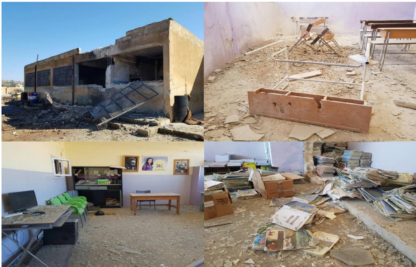
Foto1. Danni inflitti alla scuola
